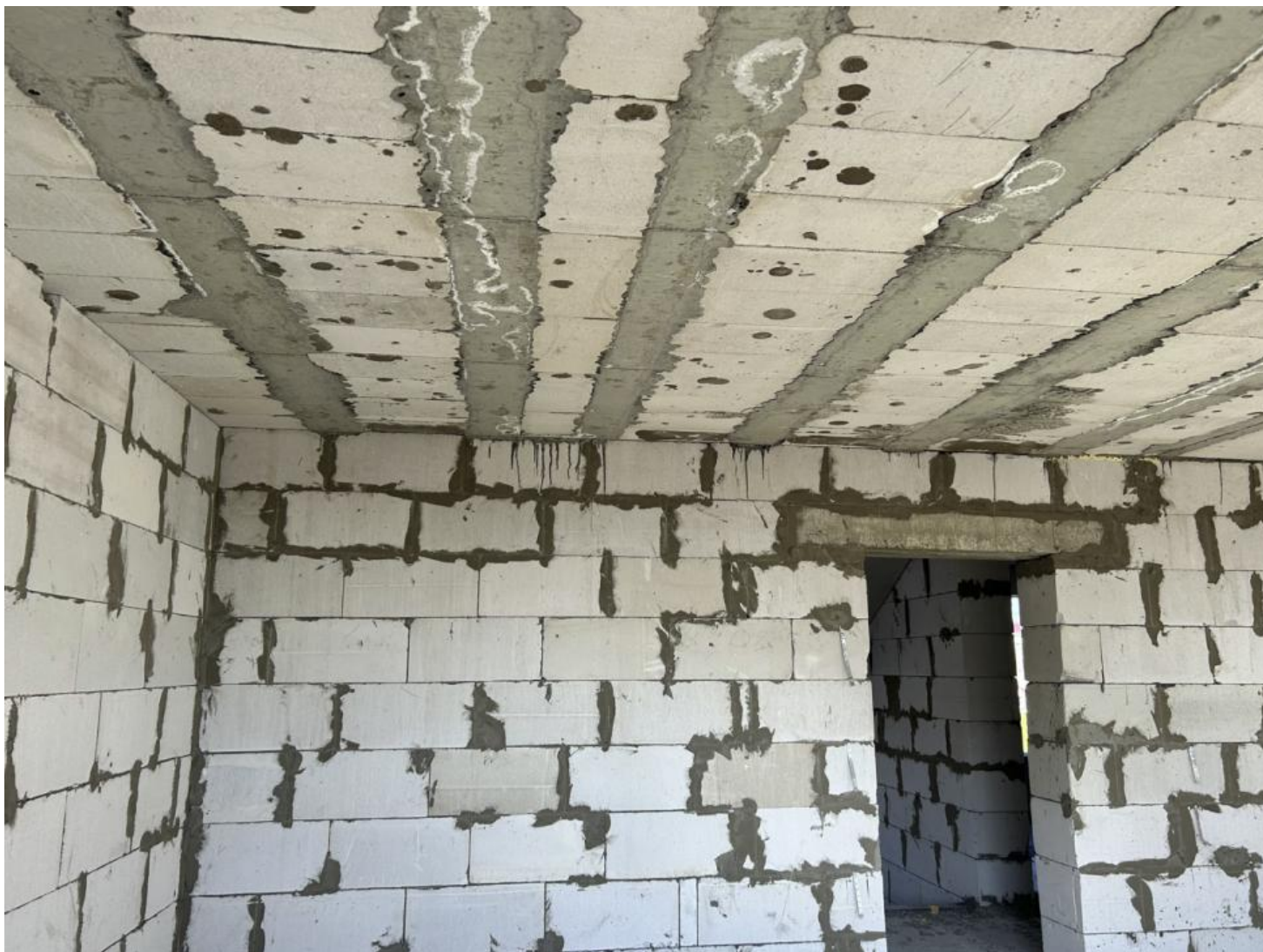
2.9-сурет – Бетондаудан кейін төменнен көрініс
