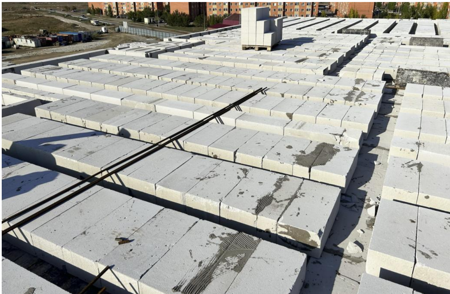
2.4-сурет - Газды блоктарды көбікпен толтыра отырып, аражабынға жайып салу
