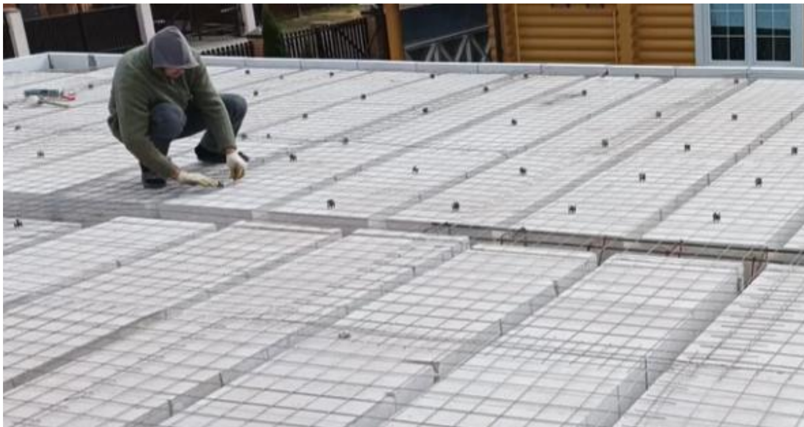
Рисунок 2.6 – Укладка строительной сетки
