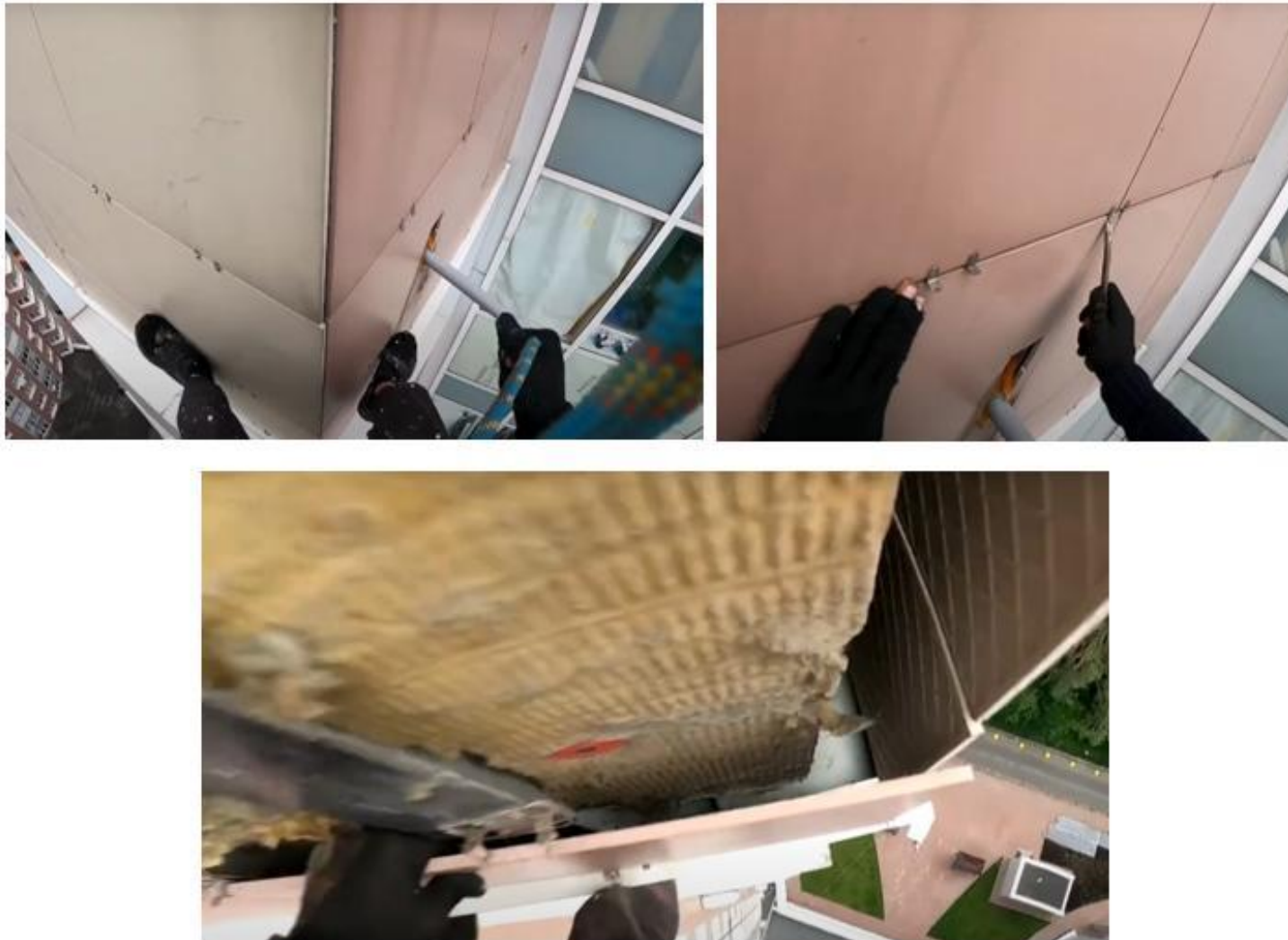
2.2-сурет – Керамогранитті бөлшектеу және монтаждау
