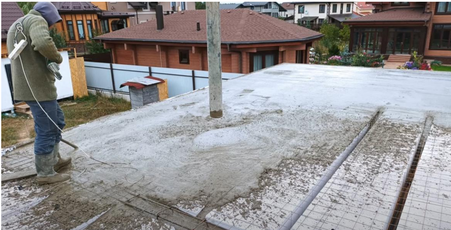
Рисунок 2.7 – Бетонирование с уплотнением
