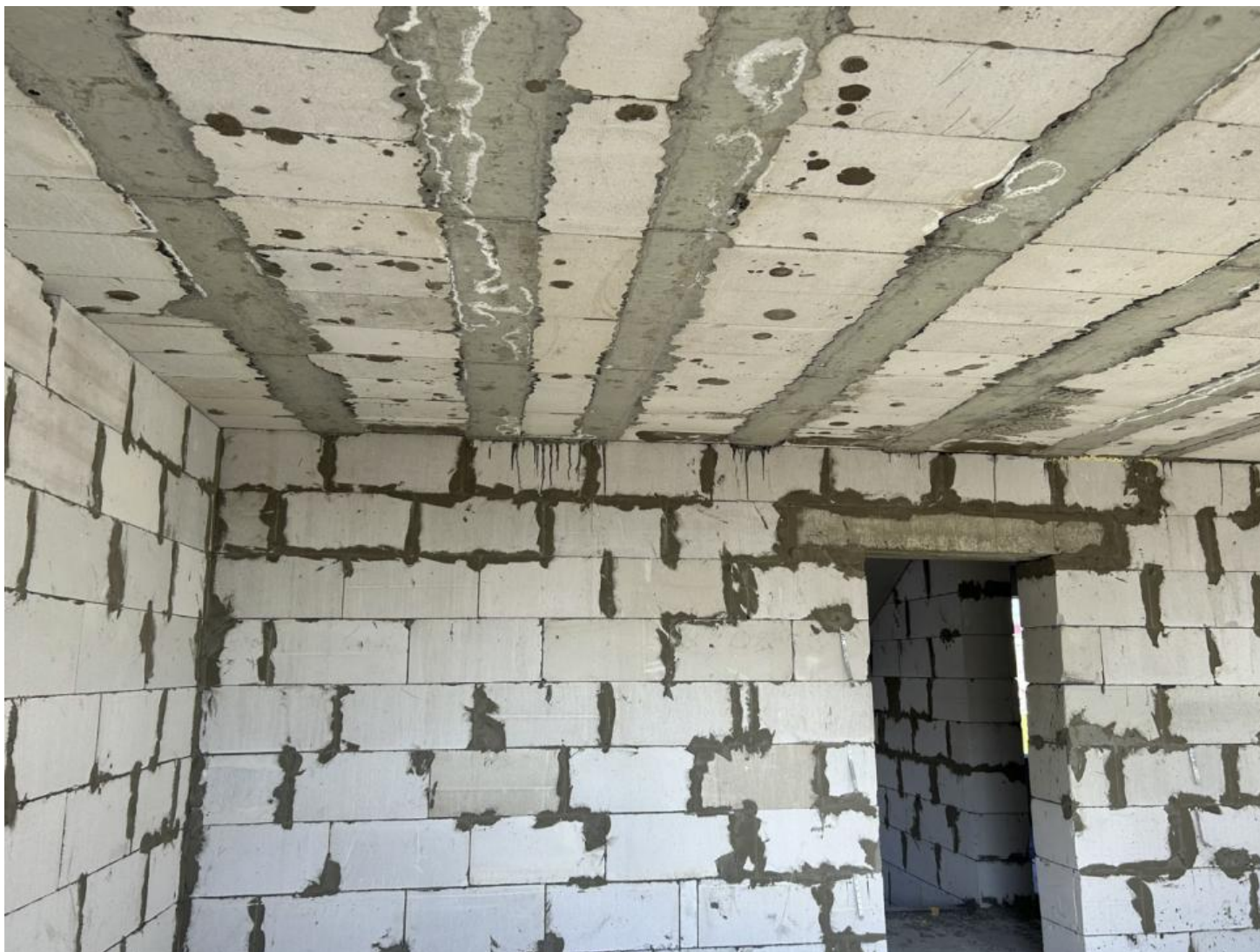
Рисунок 2.9 – Вид снизу после бетонирования
