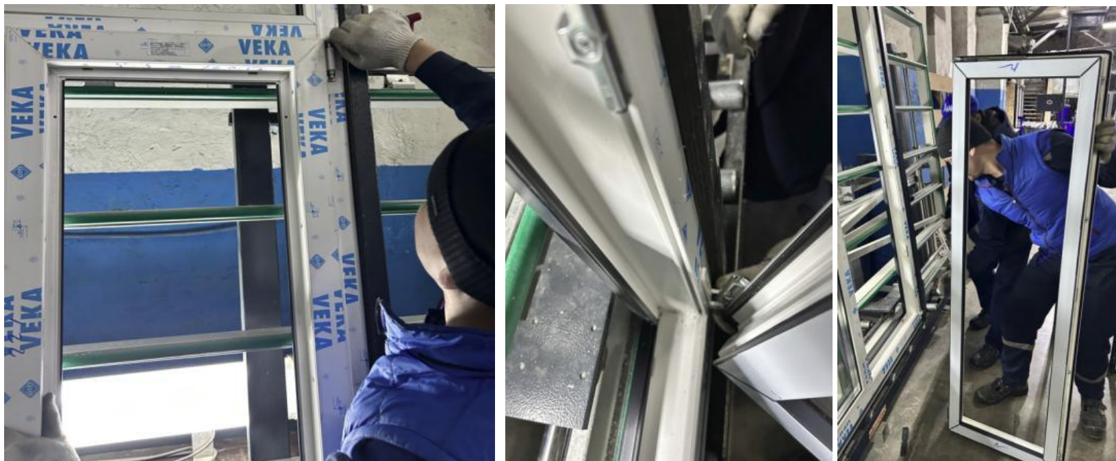
Рисунок 2.3 – Снятие оконной створки
