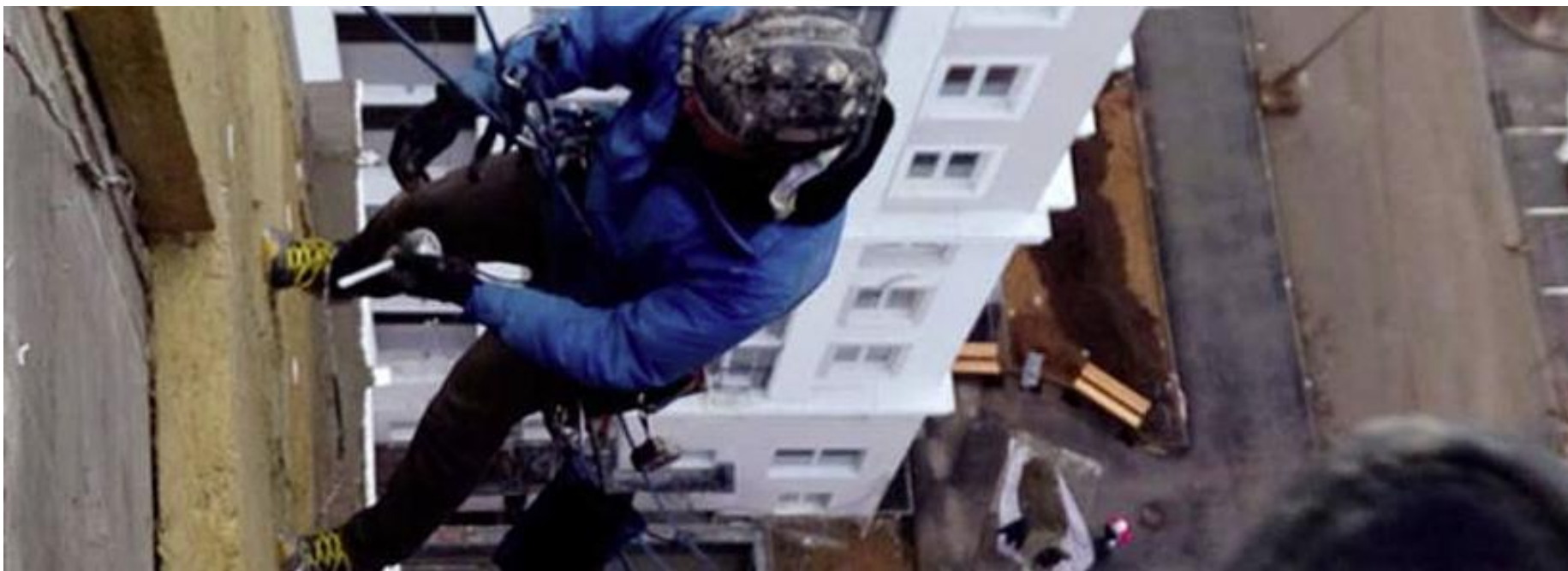
Рисунок 2.3 – Монтаж утеплителя
