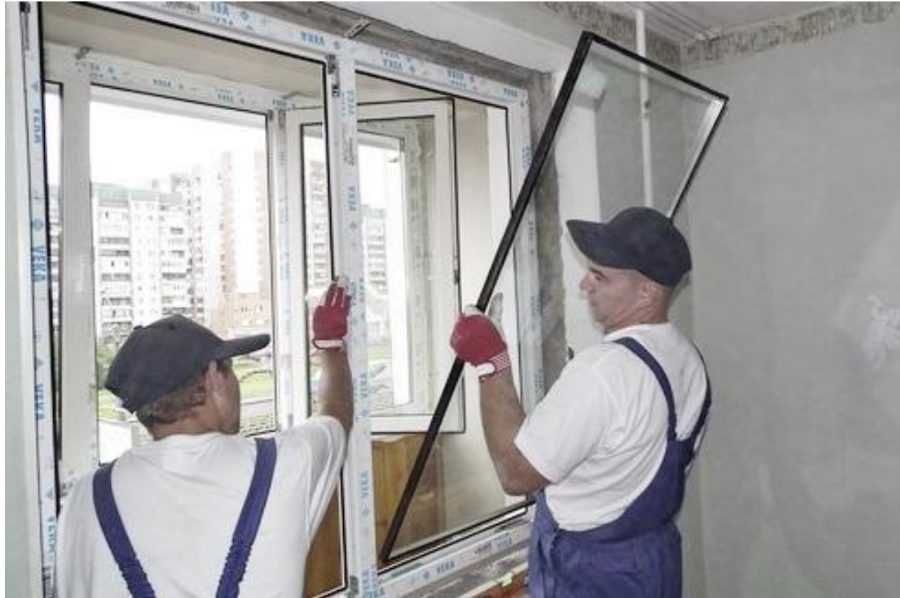
Рисунок 2.5 – Установка стеклопакета
