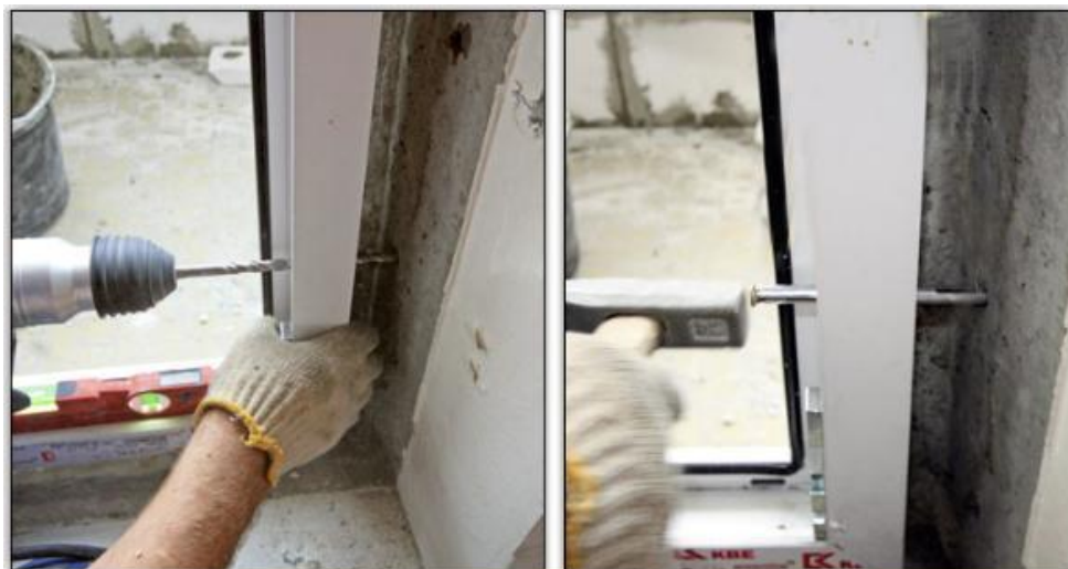
2.4-сурет - Терезе жақтауын монтаждау
