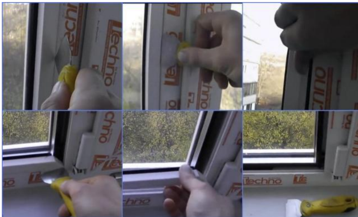
2.1-сурет - ПВХ штапиктерді алудың негізгі кезеңдері
