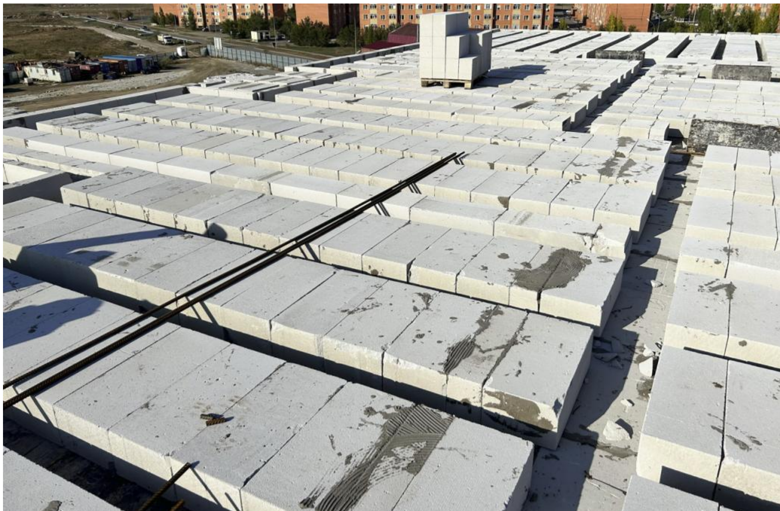
Рисунок 2.4 – Раскладка газоблоков на перекрытие с запениванием
