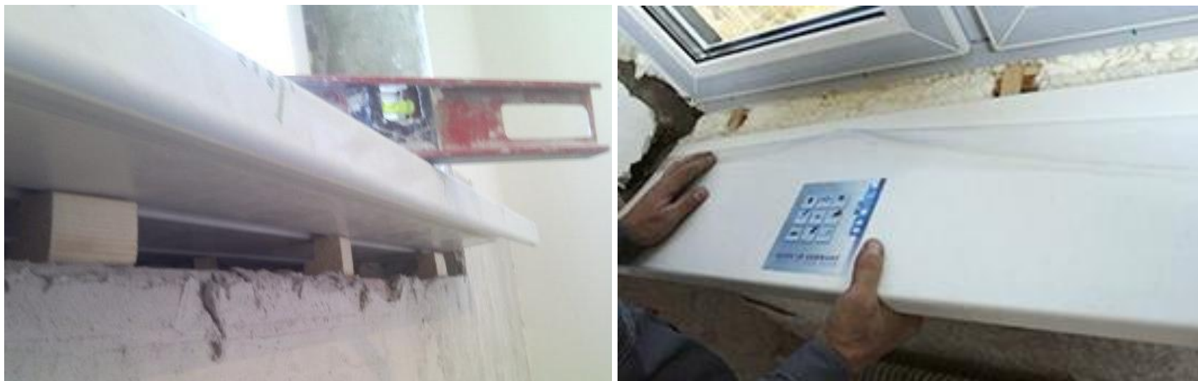
Рисунок 2.7 – Установка подоконника
