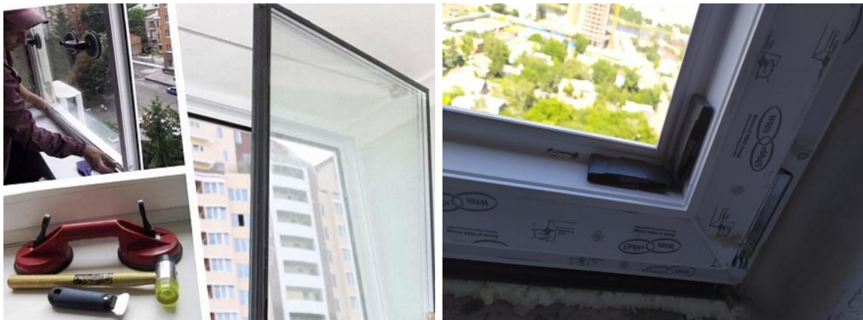
Рисунок 2.2 – Снятие стеклопакета
