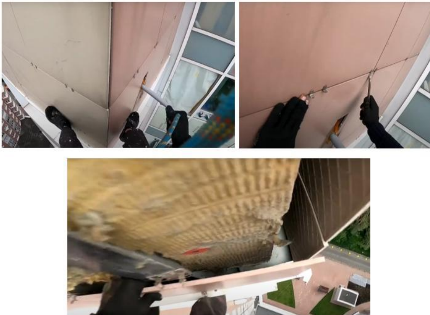
Рисунок 2.2 – Демонтаж и монтаж керамогранита
