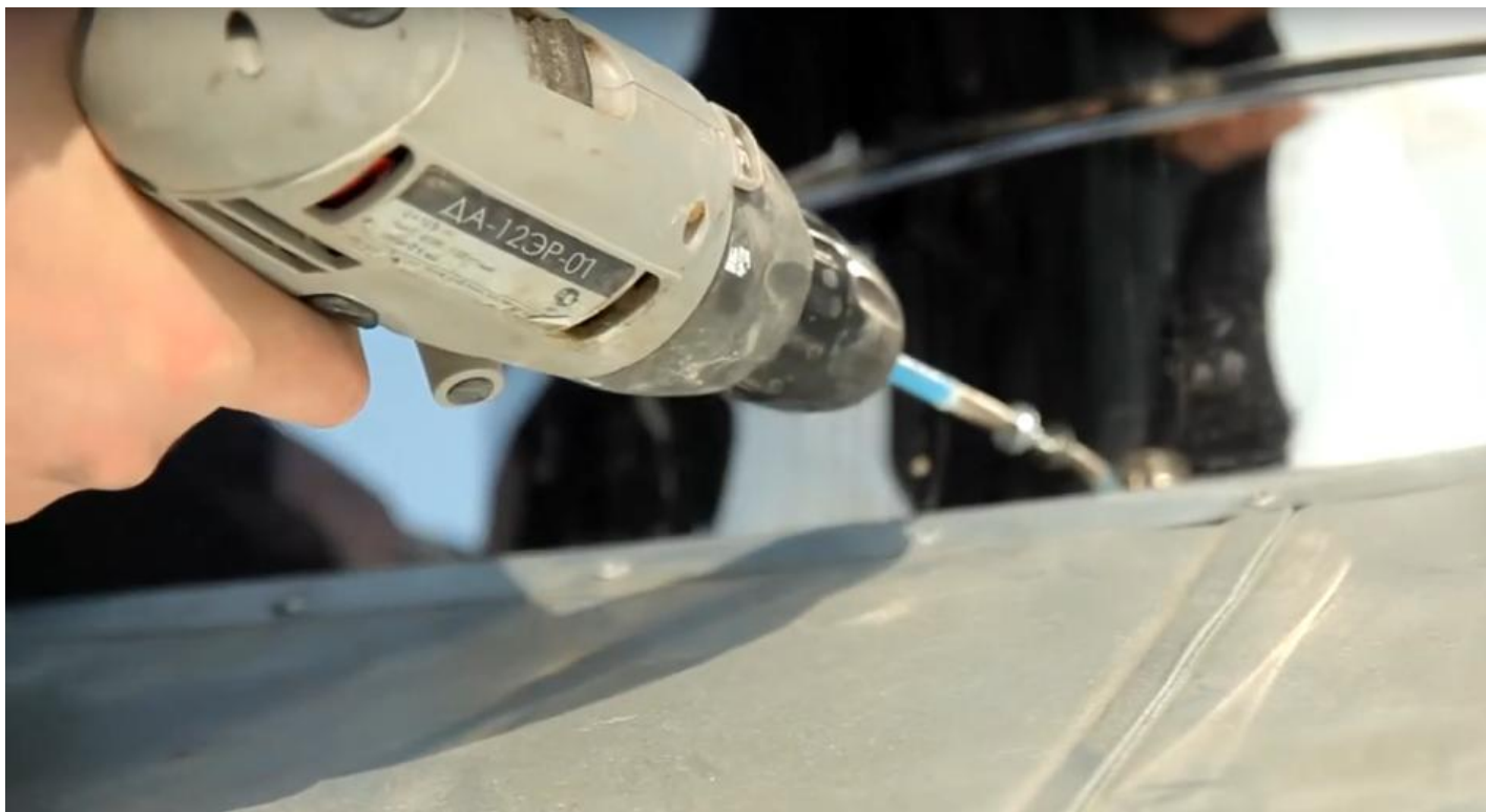
Рисунок 4 – Фиксация вентиляционных дефлекторов
