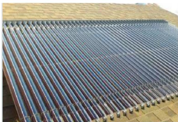
Рисунок 1 – Внешний вид вакуумных (трубчатых) солнечных коллекторов
