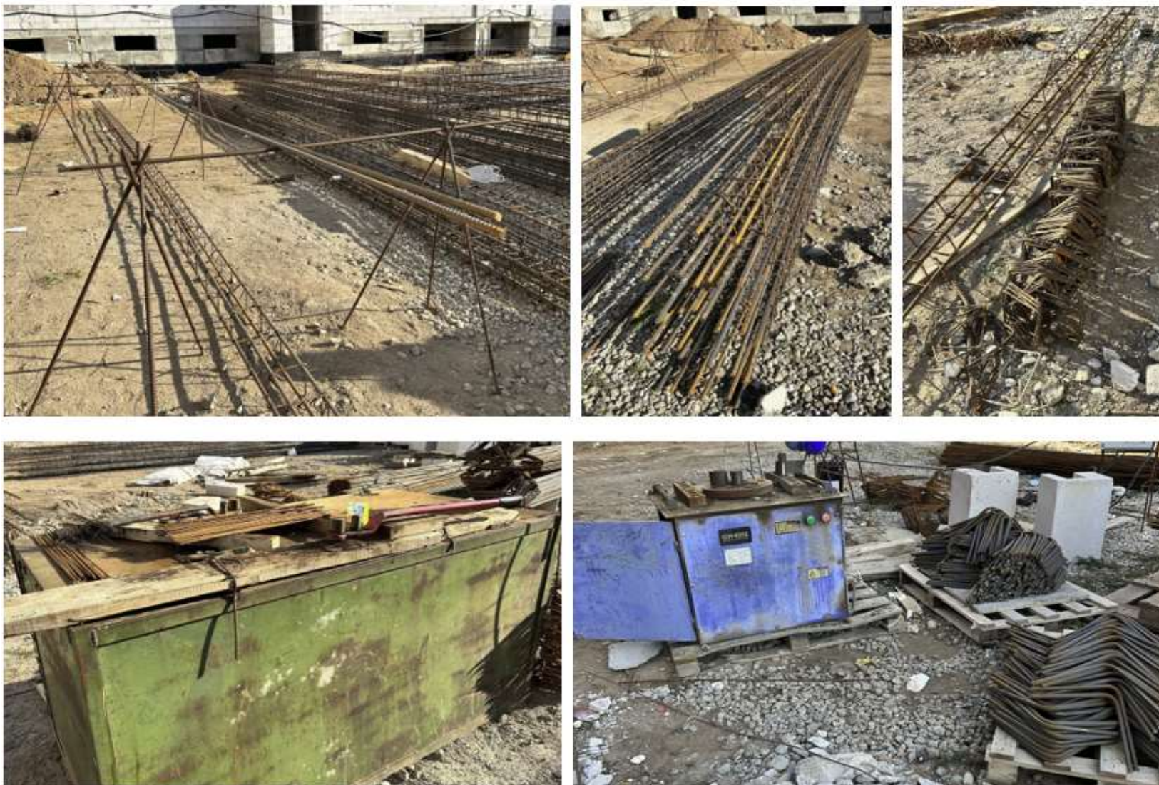
Рисунок 2.4 – Заготовка арматурных элементов
