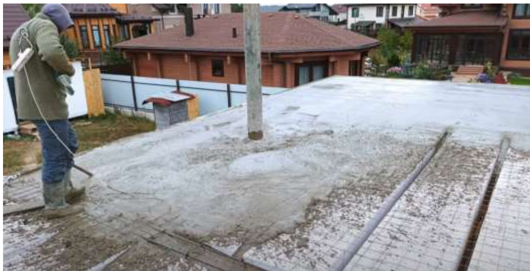
Рисунок 2.7 – Бетонирование с уплотнением
