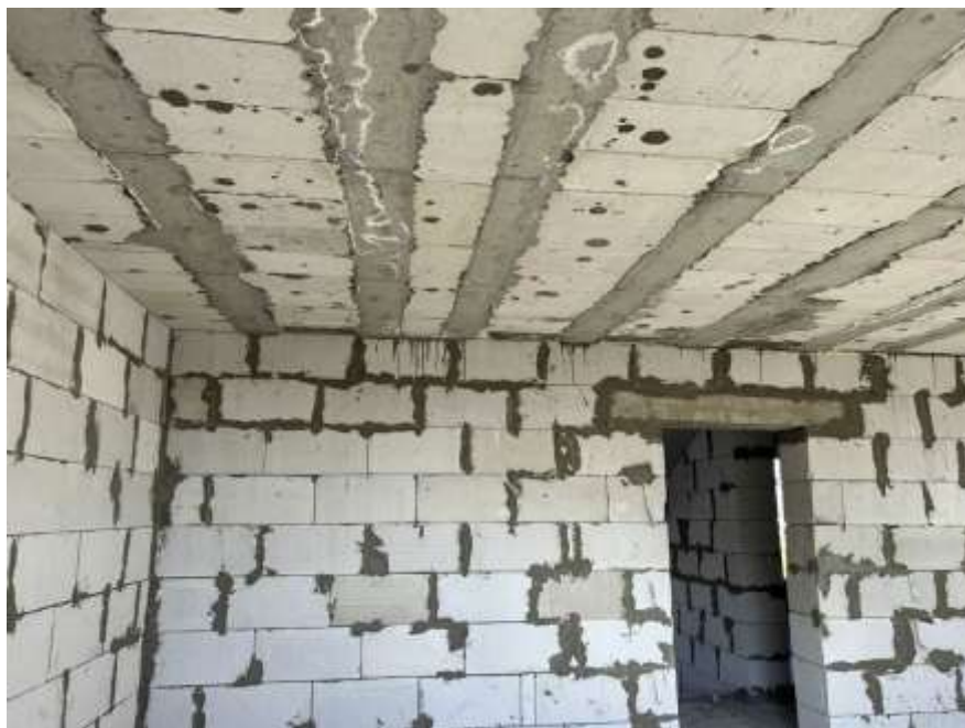
Рисунок 2.9 – Вид снизу после бетонирования
