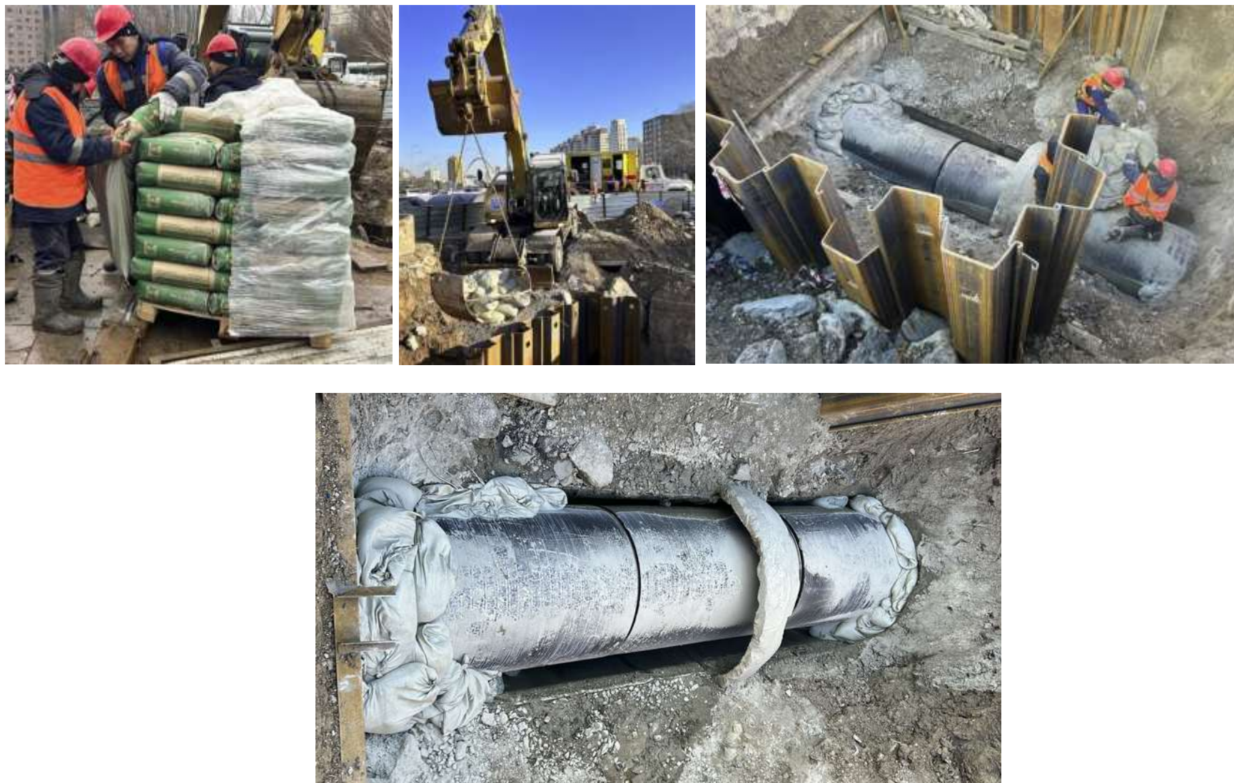
Рисунок 2.11 - Герметизация свода ж/б трубы в пределах котлованов
