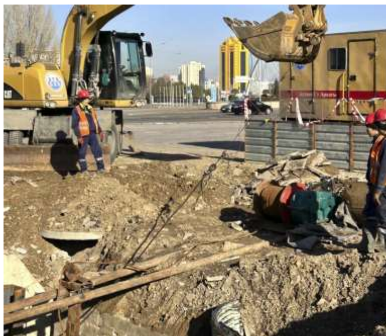
Рисунок 2.3 - Протяжка тягового каната
