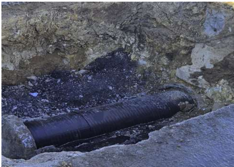
Рисунок 2.9 - Протяжка резьбовых модулей (труб) типа СПИРОЛАЙН без кондуктора
