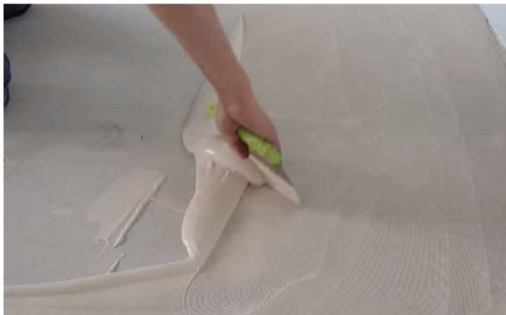
Рисунок 5 – Нанесение клея на основание
