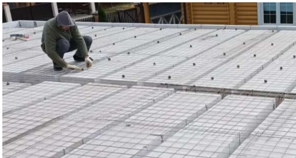
Рисунок 2.6 – Укладка строительной сетки
