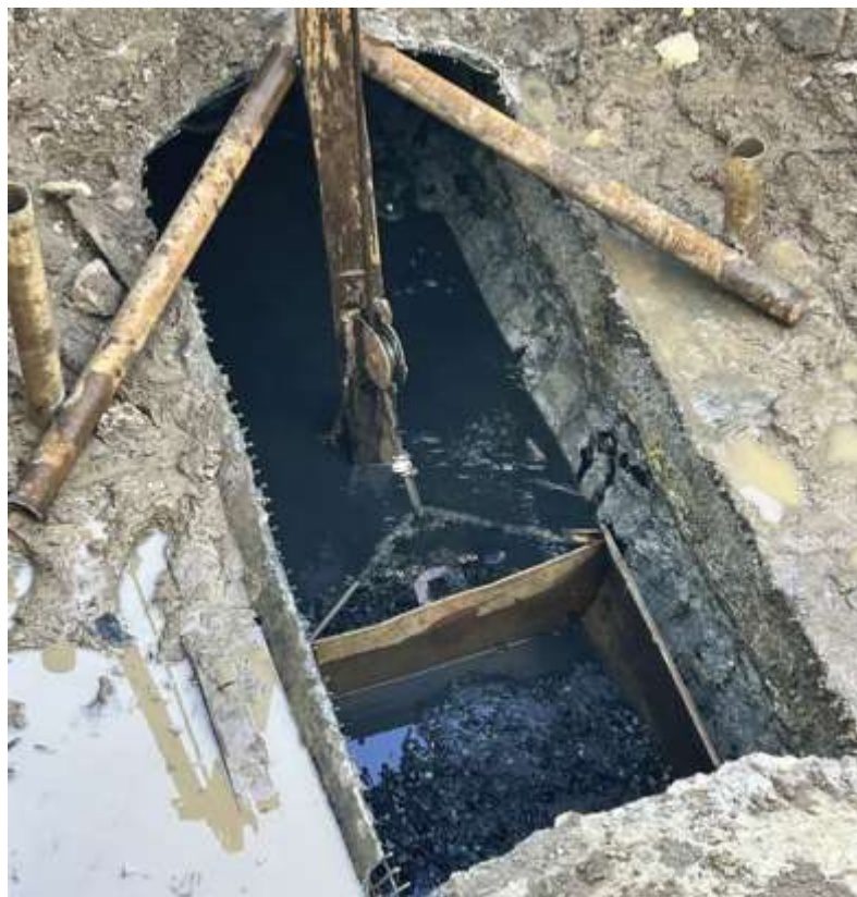
Рисунок 2.5 - Механическая прочистка трубопровода
