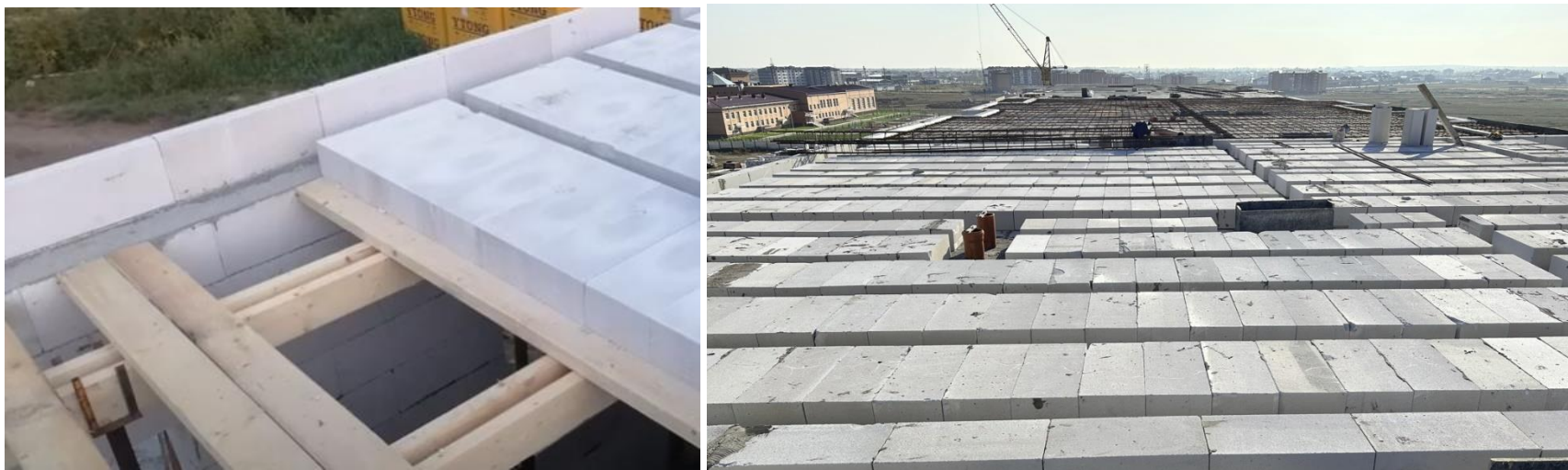
2.3-сурет - Газды блоктарды көбікпен толтыра отырып, аражабынға жайып салу
