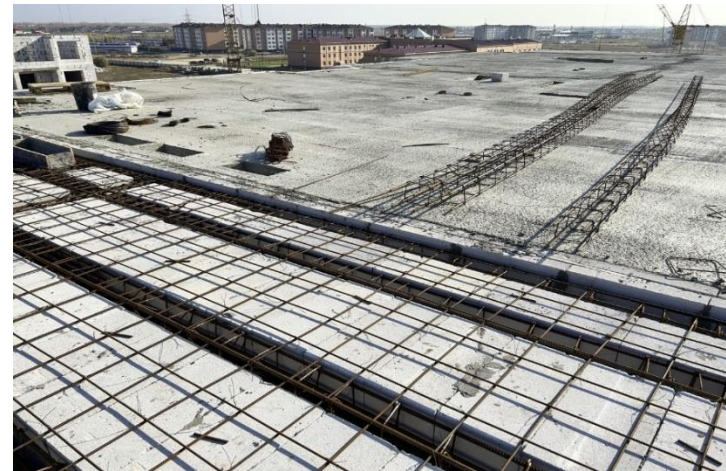
2.8-сурет – Бетондалған аражабын
