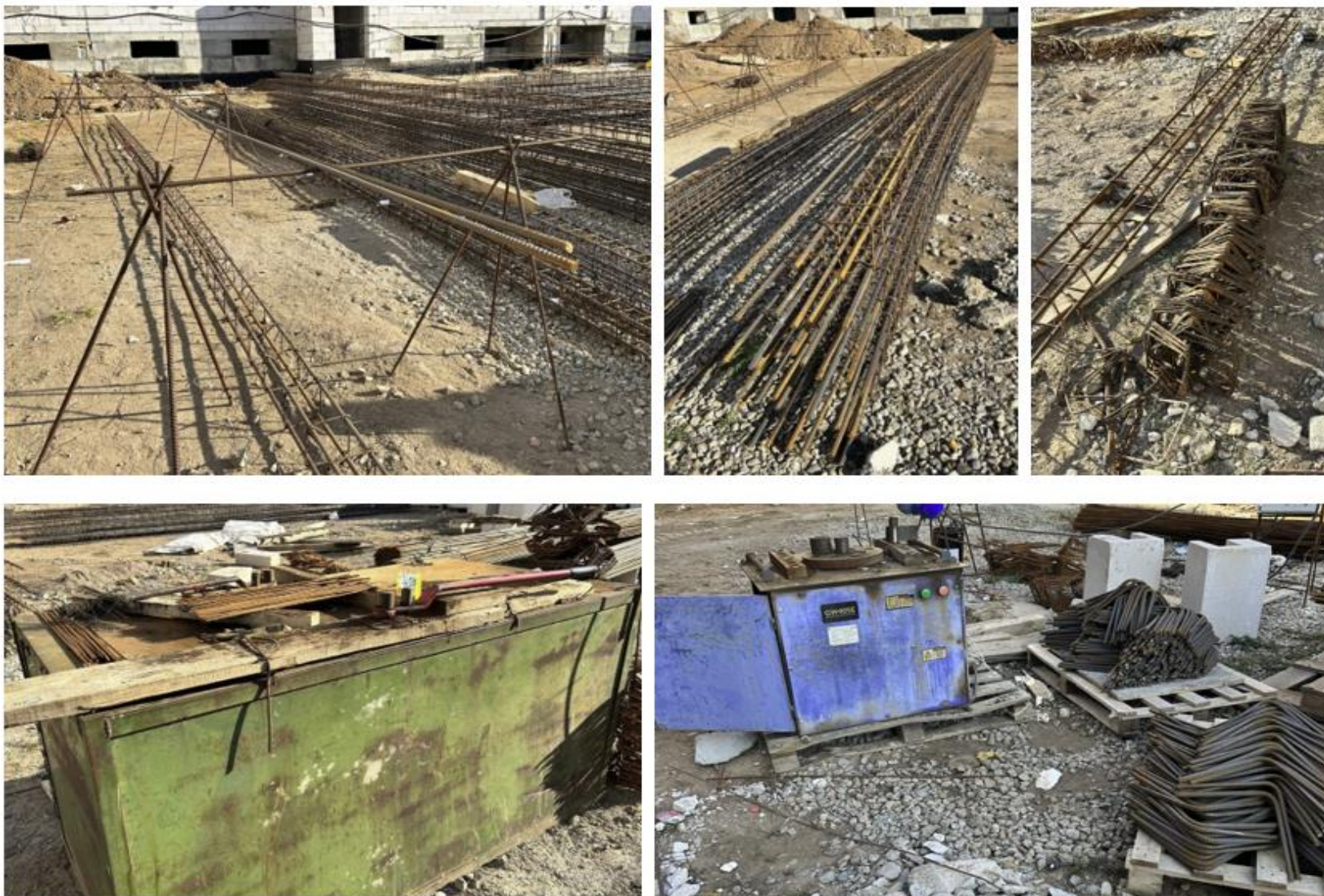
2.4-сурет – Арматуралық элементтерді дайындау
