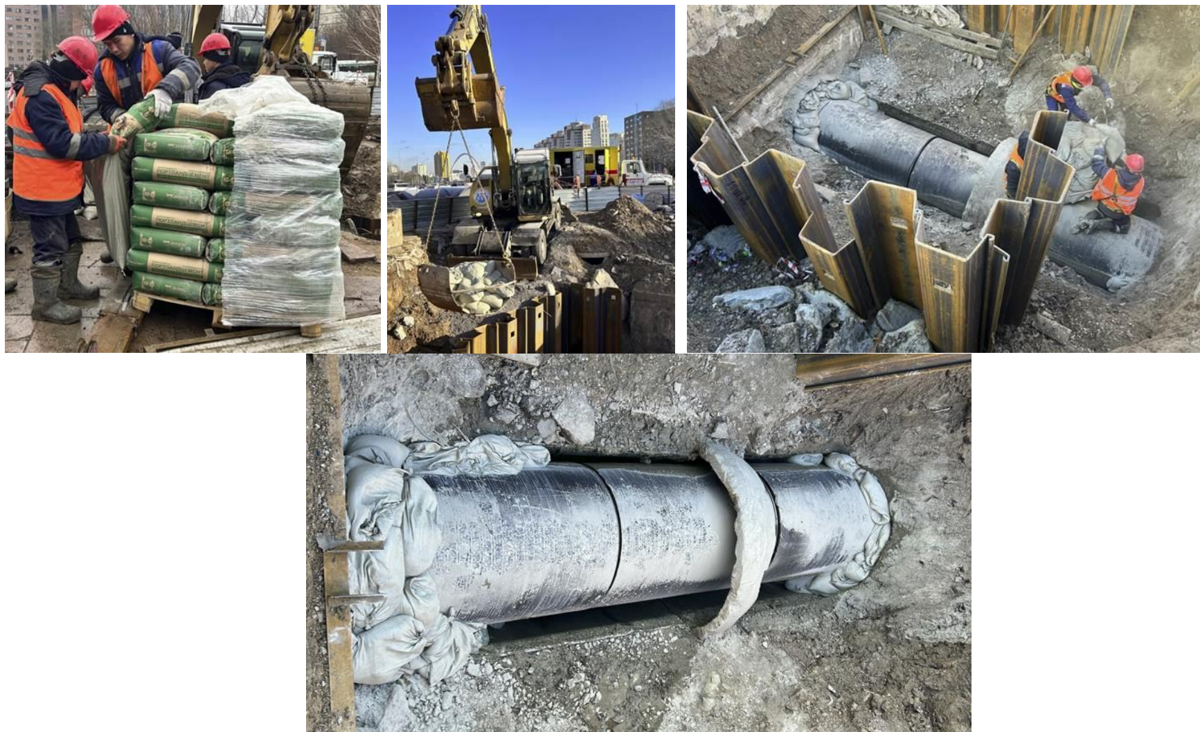
2.11-сурет - Қазаншұңқырлар шегінде т/б құбыр тоғыспасын герметикалау
