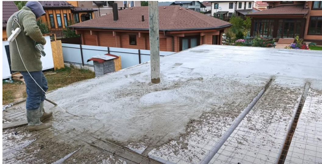
2.7-сурет – Тығыздай отырып бетондау
