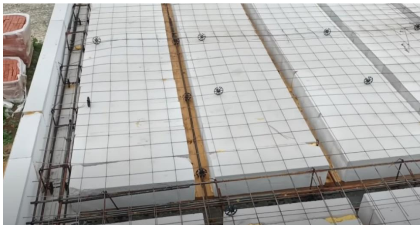
2.5-сурет - Аражабынды арқаулау
