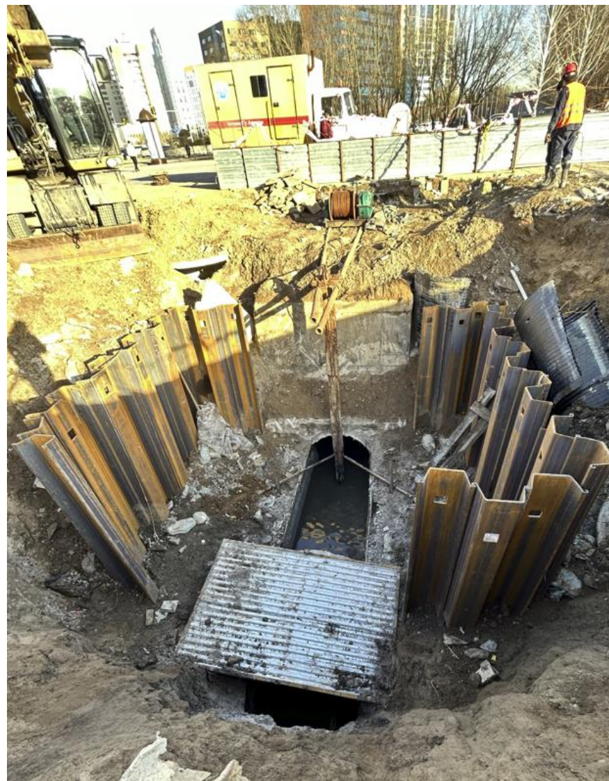
2.2-сурет –Тарту жүкшығырларын монтаждау
