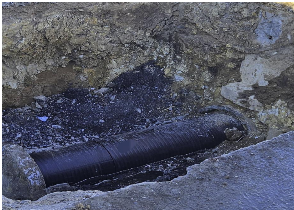
2.9-сурет - СПИРОЛАЙН типті бұрандалы модульдерді (құбырларды) кондукторсыз тарту
