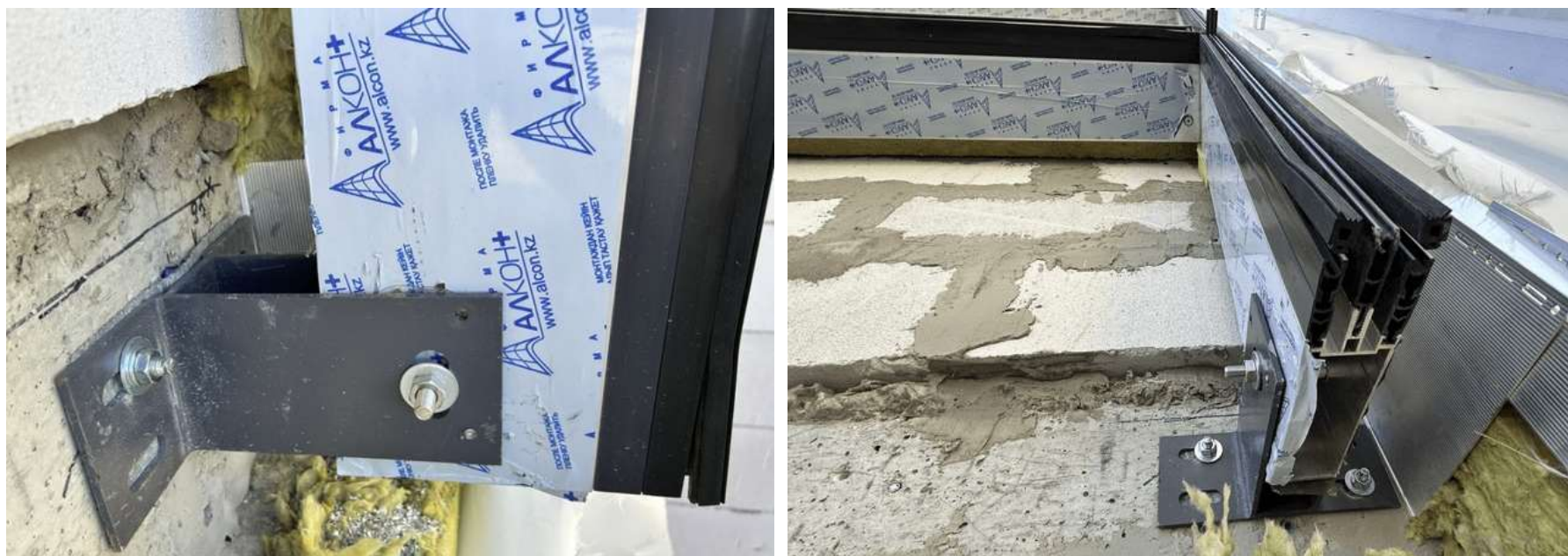
1.8 сурет – Қабатаралық плиталар бойынша орнатылған кронштейндер
