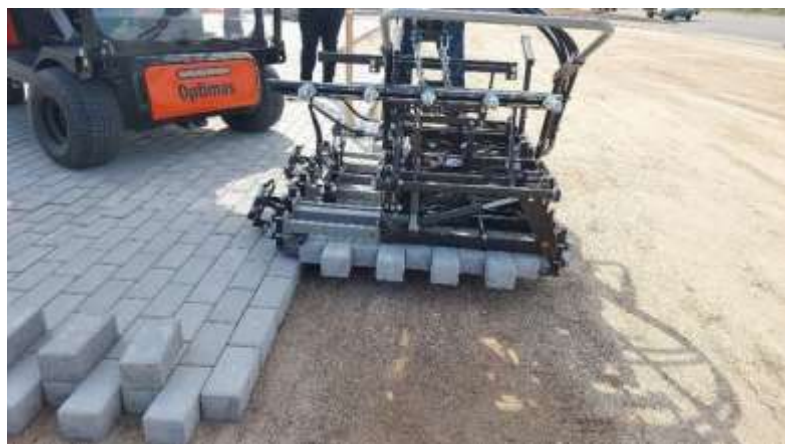
7 сурет – Бетон тротуар плиталарын механикаландырылган төсеу
