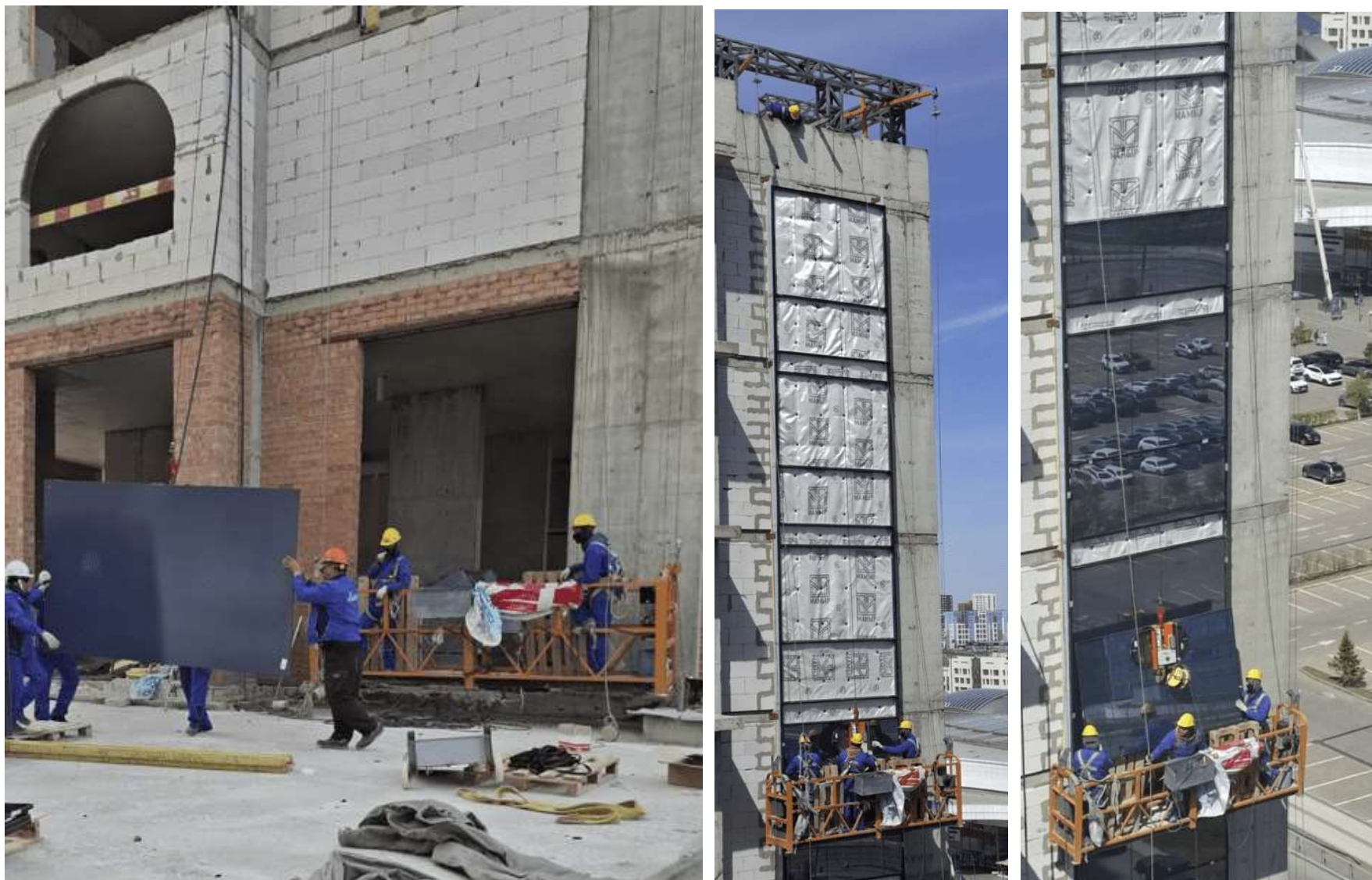
1.10-сурет – Әйнек пакеттерін монтаждау
