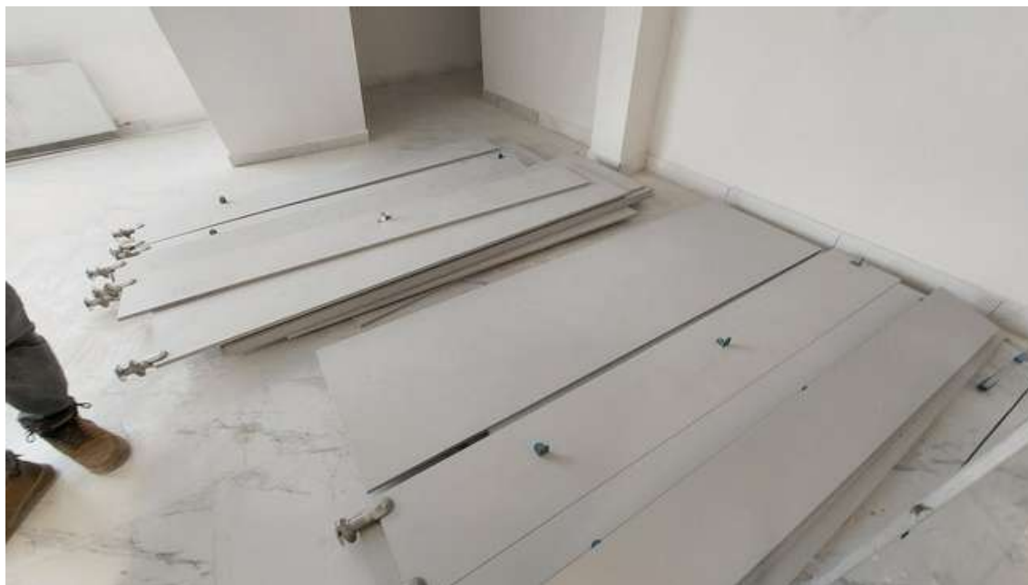
6 Сурет – Аяқ тіректерін және бекіту элементтерін орнату
