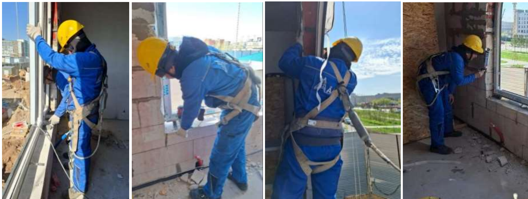
5 Сурет Терезе блогын ПВХ профильдерінен ойыққа орнату
