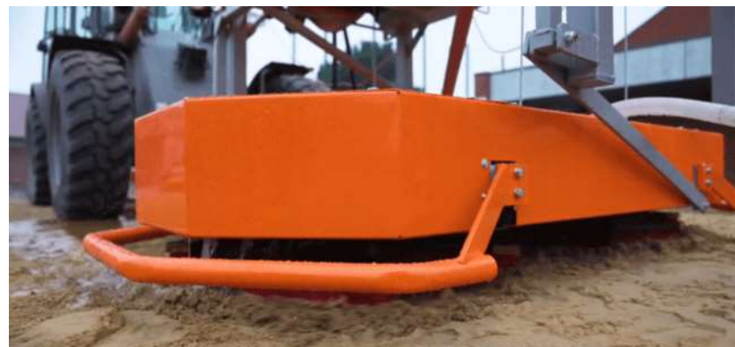
9 сурет – Плитка жіктерін құммен толтыру
