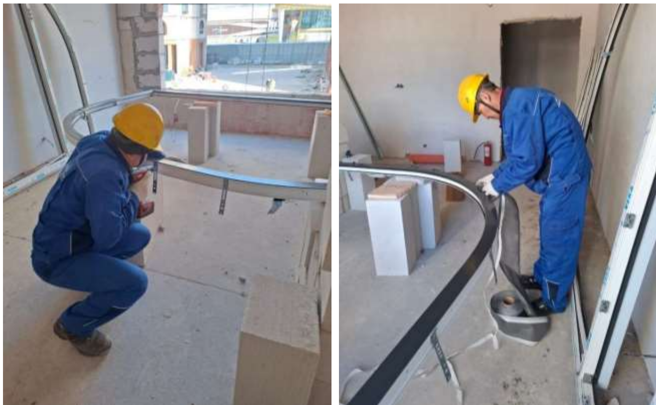
4-сурет – Анкерлік пластиналарды бекіту және тығыздағыш ленталарды жапсыру
