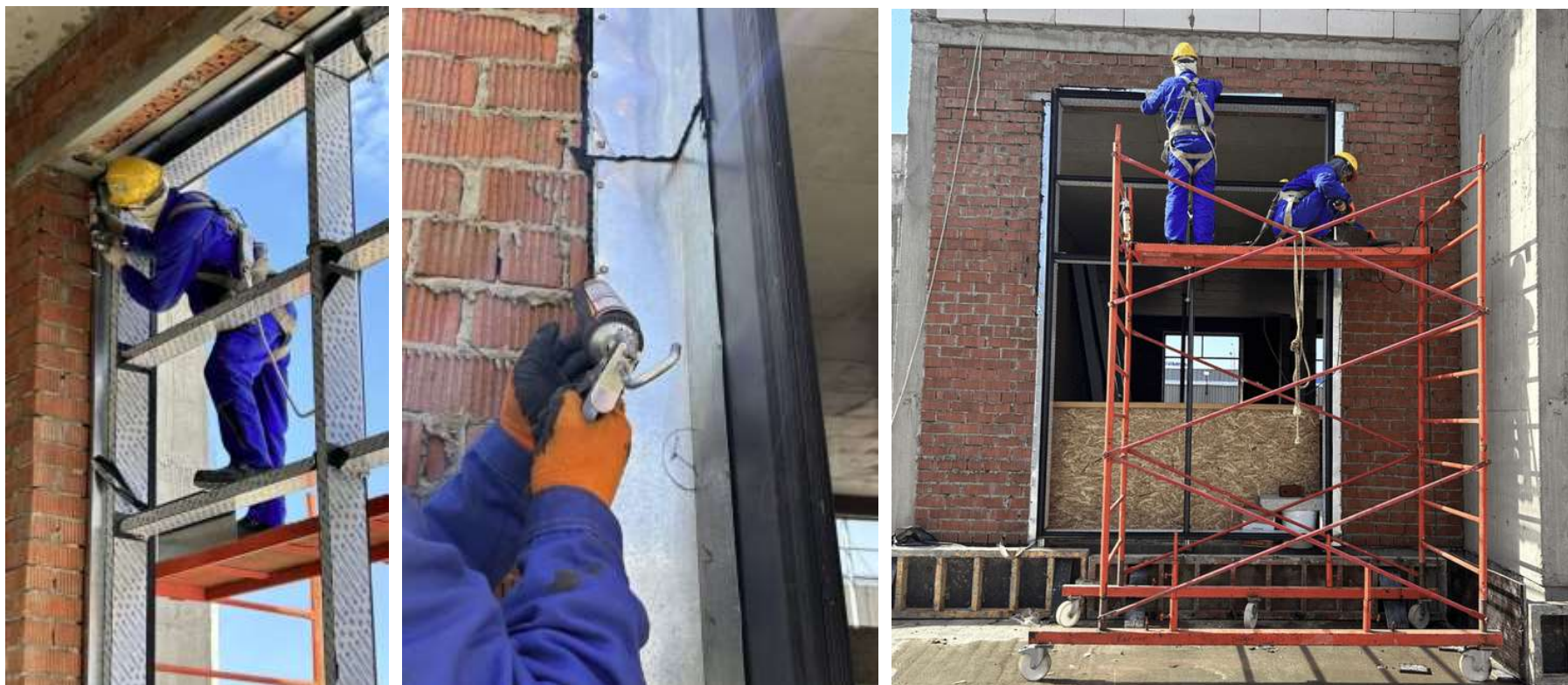
1.11 сурет – Ойық периметрін мырышталған болаттан жасалған өртке қарсы тосқауылмен жабдықтау
