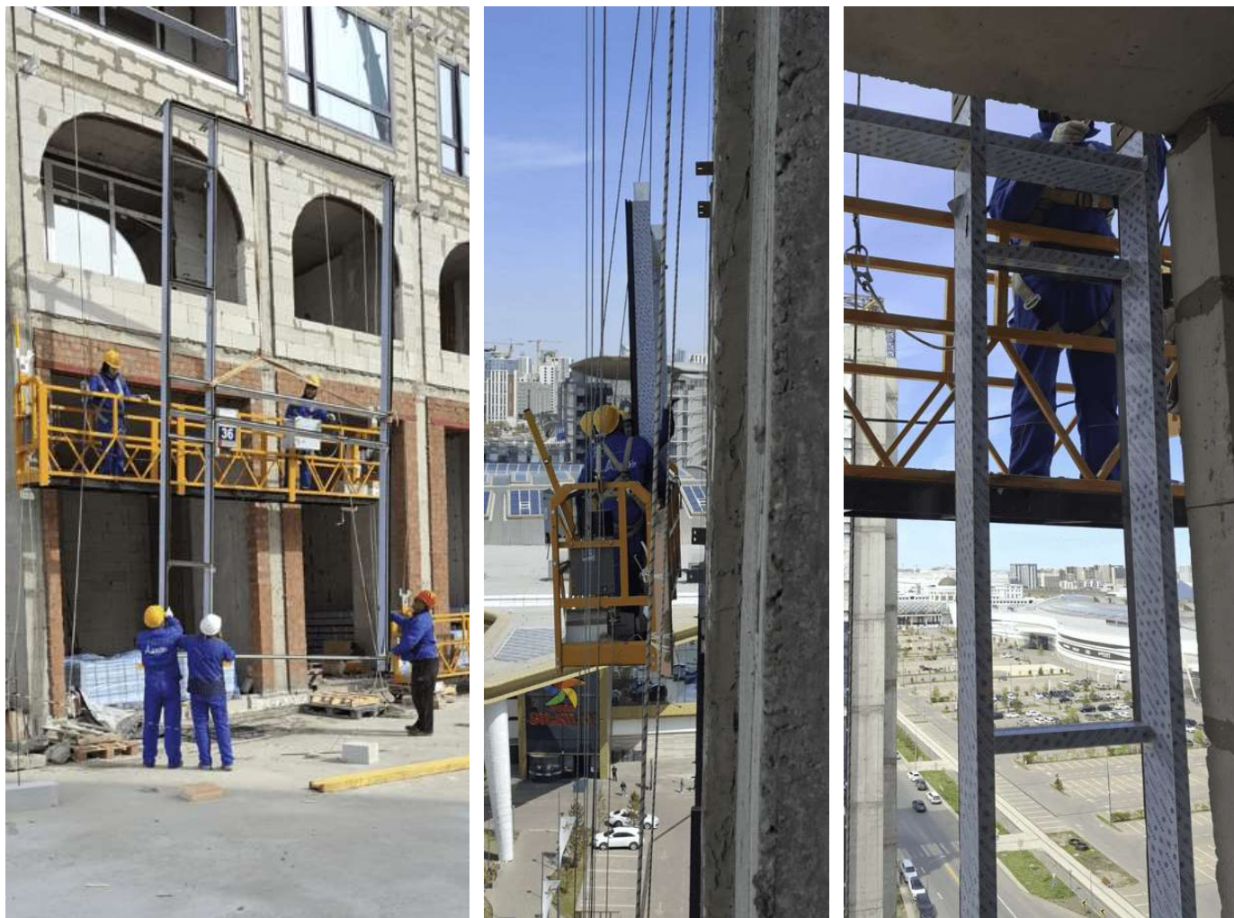
1.10-сурет – Витраж рамасын ойыққа көтеру және кронштейндерге бекіту
