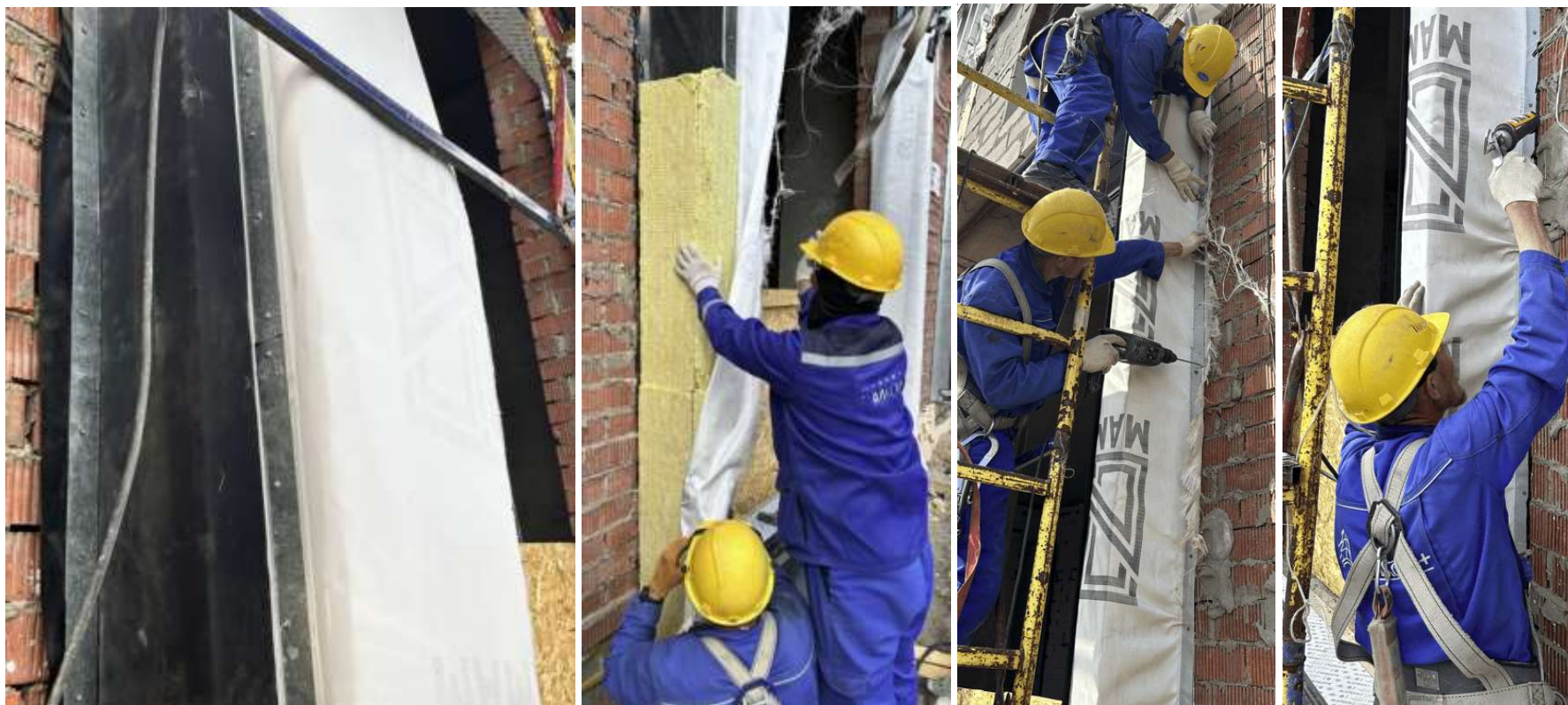
1.11-сурет – Витраж рамасының ойығын герметизациялау
