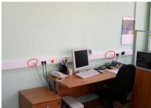
Рис. 9.2 Телекоммуникационные розетки
