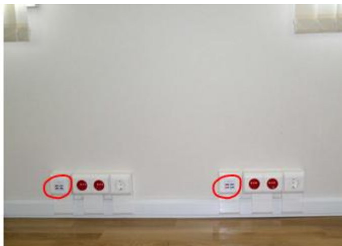
Рис.7.10 Телекоммуникационные розетки
