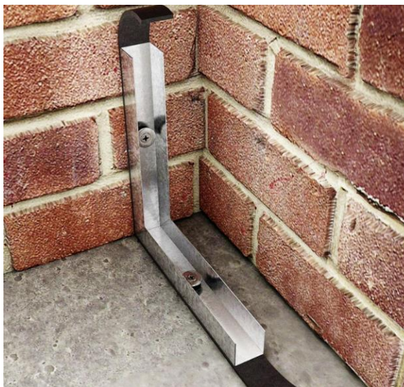
13-сурет - Бағыттағыш профильді еденге бекіту
