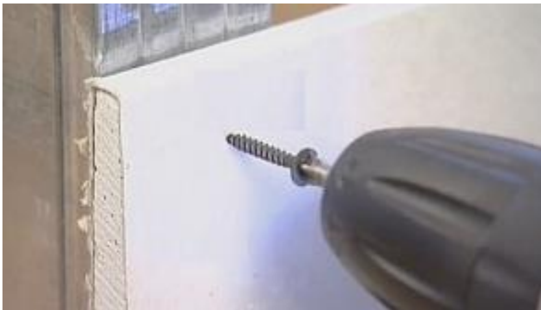
19-сурет – Гипсокартонды профильге бұрандалы шегелермен бекіту
