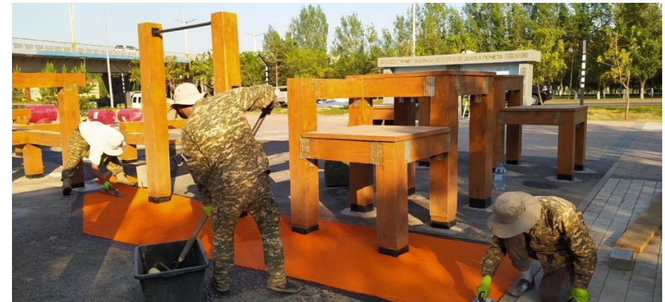
11-сурет - Резеңке жабынның құрылғысы
