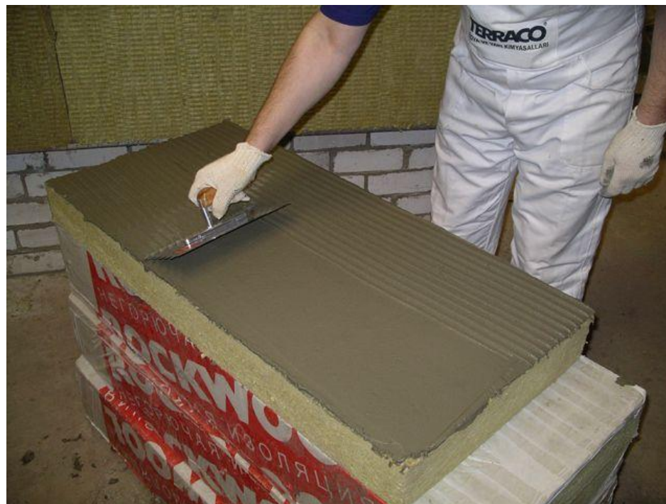
15-сурет - Минералды мақта тақта бойынша желімнің тісті қалақшамен бөлінуі
