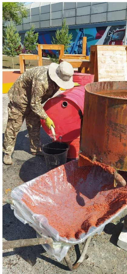
8-сурет - Резеңке жабынды дайындау процесі
