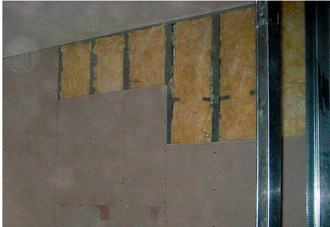
20-сурет – Жылытумен металл қаңқа бойынша гипсокартонмен қапталған қабырғаның фрагменті
