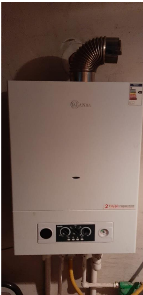
6-сурет - Қабырғаға орнатылатын жылыту газ қазанының жалпы көрінісі
