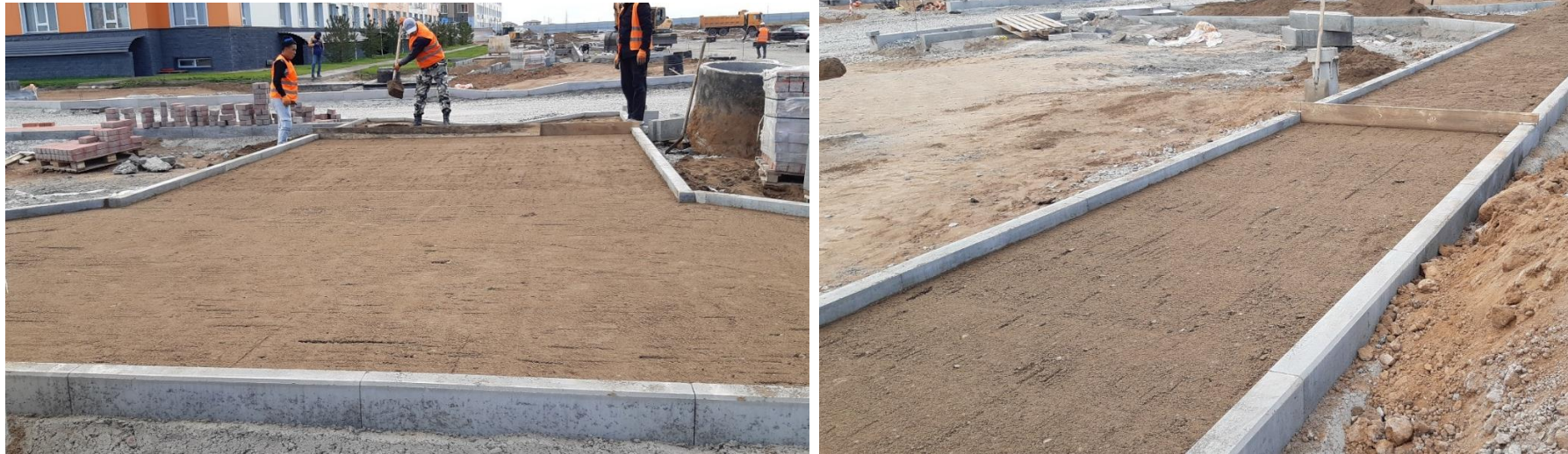
16-сурет - Құм негізінің жоғарғы монтаждау қабатының құрылғысы
