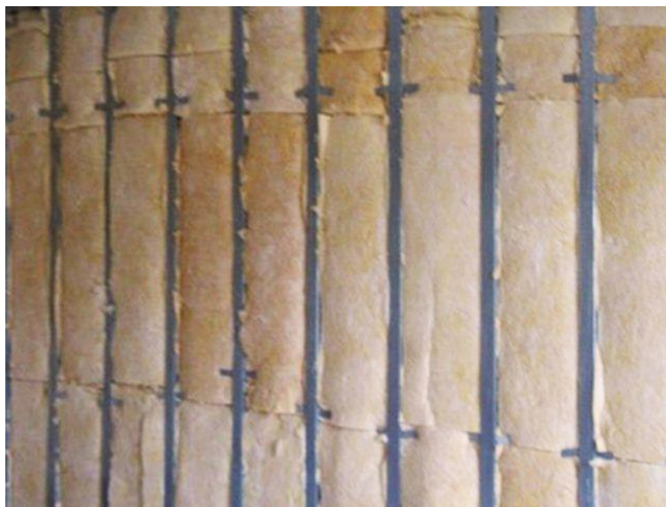
18-сурет - Минералды мақта бойынша тік аспаларға бекітілген тіреулер
