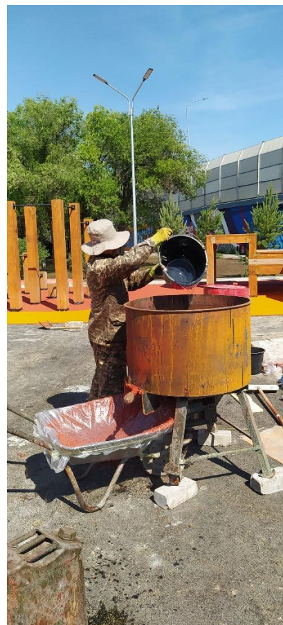
8-сурет - Резеңке жабынды дайындау процесі
