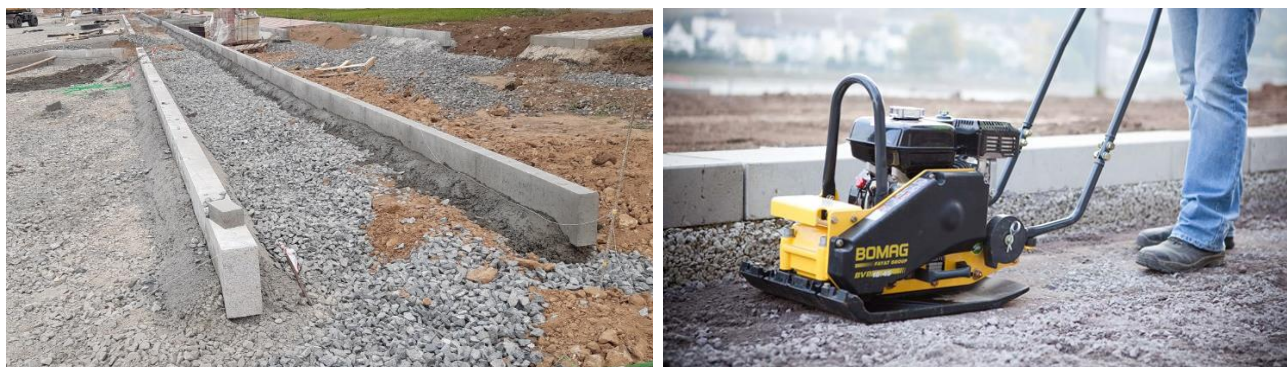
15-сурет - Шағыл тас негізінің ортаңғы көтергіш қабатының құрылғысы
