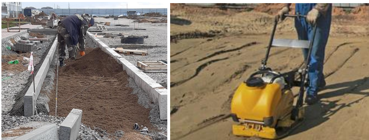
14-сурет - Құм негізінің төменгі тегістеу қабатының құрылғысы
